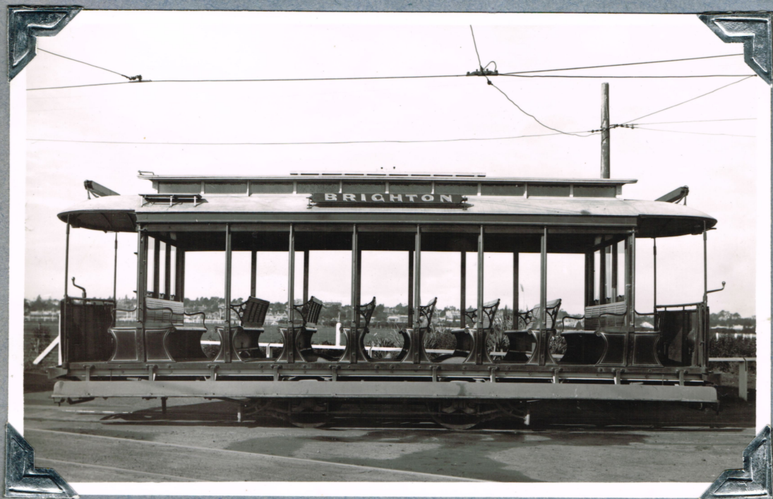
N° 13 trailer Elwood depot.
